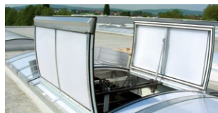
Dvojitá klapka JET-VARIO-THERM DK 95°
